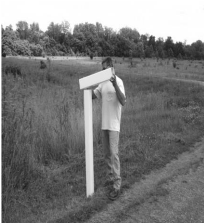
STEP 4 INSTALL ARM Instalar el brazo
