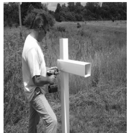
STEP 6 SECURE ARM Brazo de forma segura
