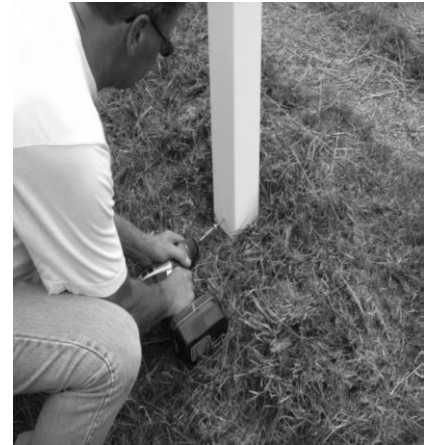
STEP 3 SECURE VERTICAL SLEEVE Asegure vertical en manga
